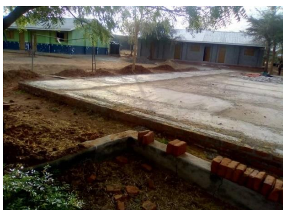
Fundering van het derde blok met klaslokalen
